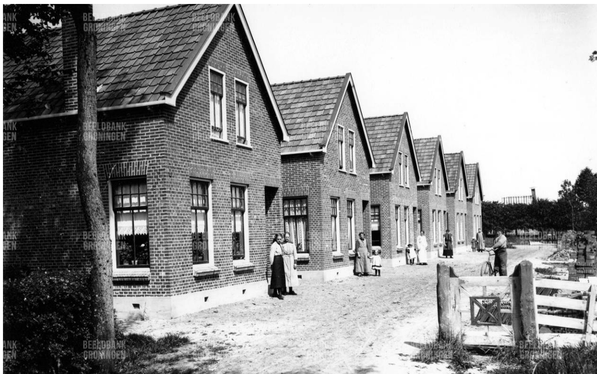
Figuur 17: Pas opgeleverde woningen aan de straat Randel in Marum. De foto is genomen tussen 1913 en 1923. Vijf van de zes huizen staan hier nog altijd. Bron: www.beeldbank groningen.nl , uit de collectie Kramer.
